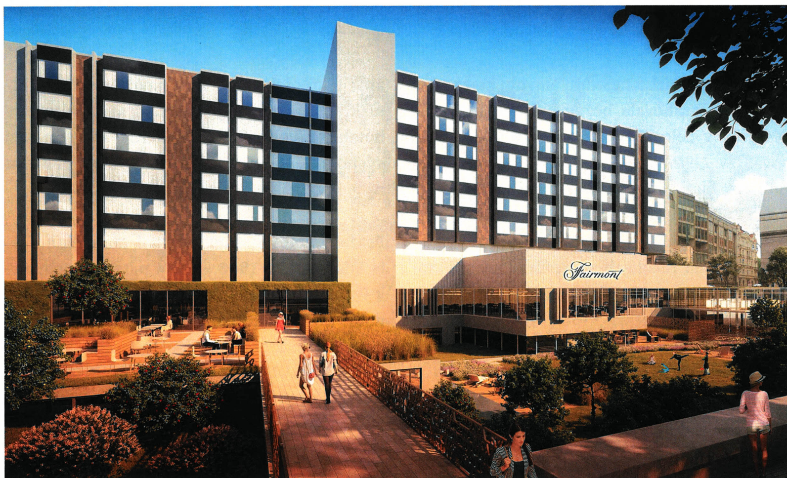
Pohled na hotel z nábrežního chodníku. Foto: neoVISUAL.cz
